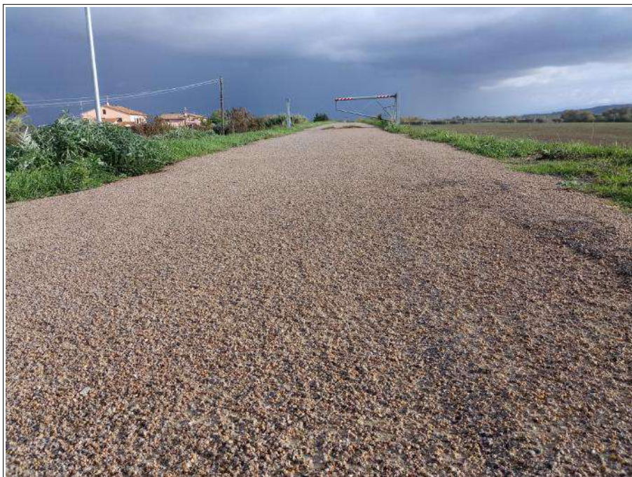
Tratto della pista ciclabile che collega Grosseto al ponte del fiume Ombrone: è possibile così osservare il futuro aspetto del nuovo percorso, che verrà realizzato mediante lo stesso processo di depolverizzazione
