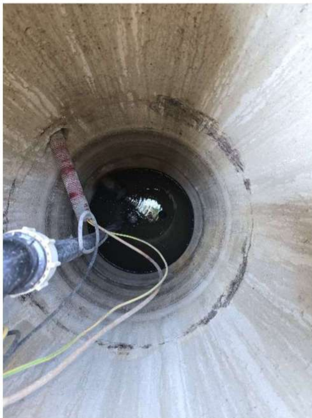
Pozzetto con pompa
